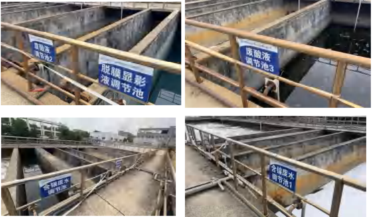
含重金属废水调节池
