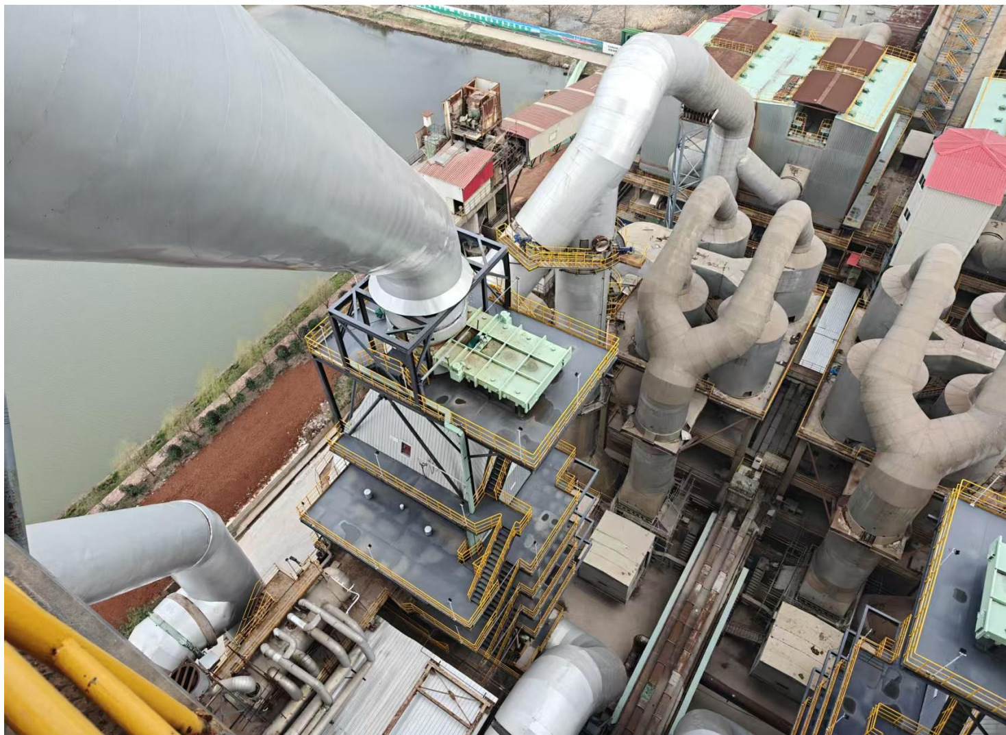
5#炉列 SCR 反应器
