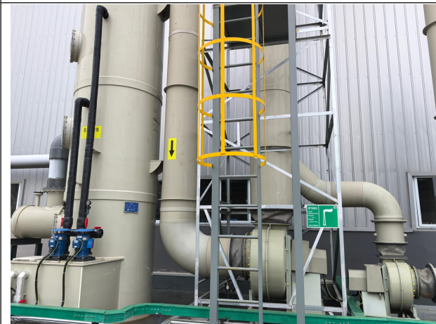
硫酸铜晶体干燥废气处理设施
