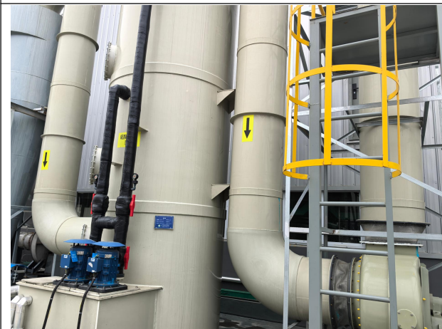
硫酸铜晶体干燥废气处理设施
