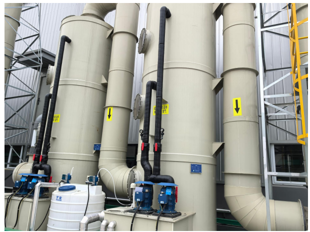
硫酸铜溶液、硫酸铜晶体酸性废气处理设施
