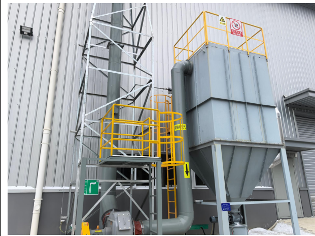
锡熔化、铸球废气、燃气燃烧废气处理设施
